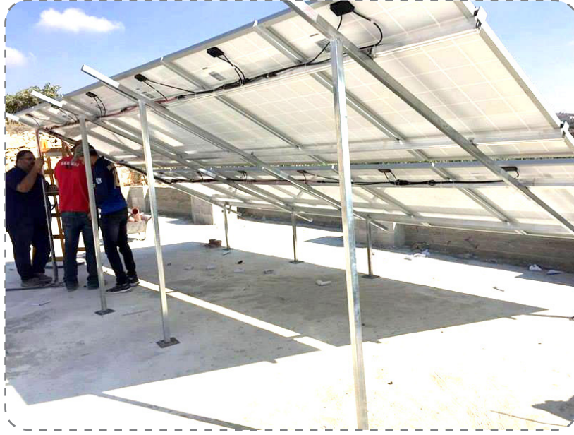
الشكل (2): تثبيت أسلاك الألواح الشمسية بالهيكل المعدني
